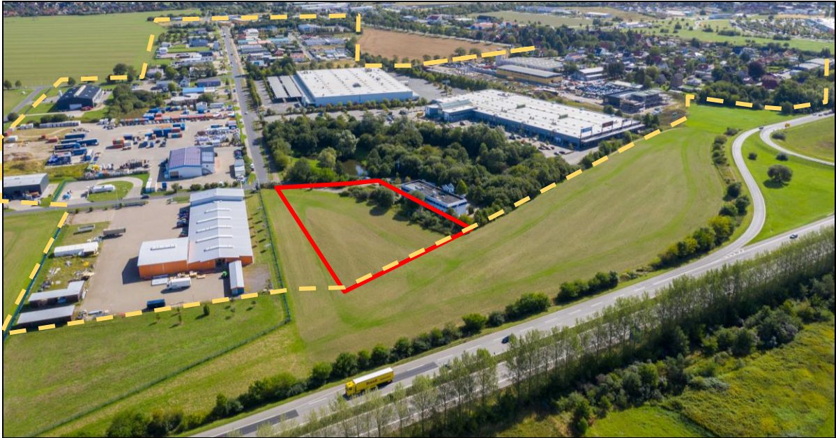
Abbildung 3: Blick aus Westen auf den Planungsraum (Geltungsbereich rot; Innenbereich gelb)
